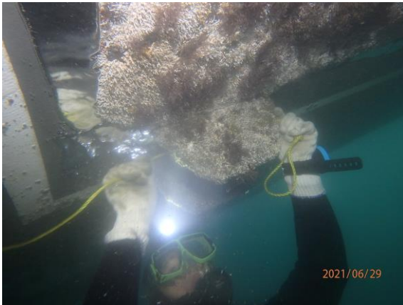
水下音鼓施工中
