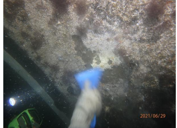
水下音鼓施工中
